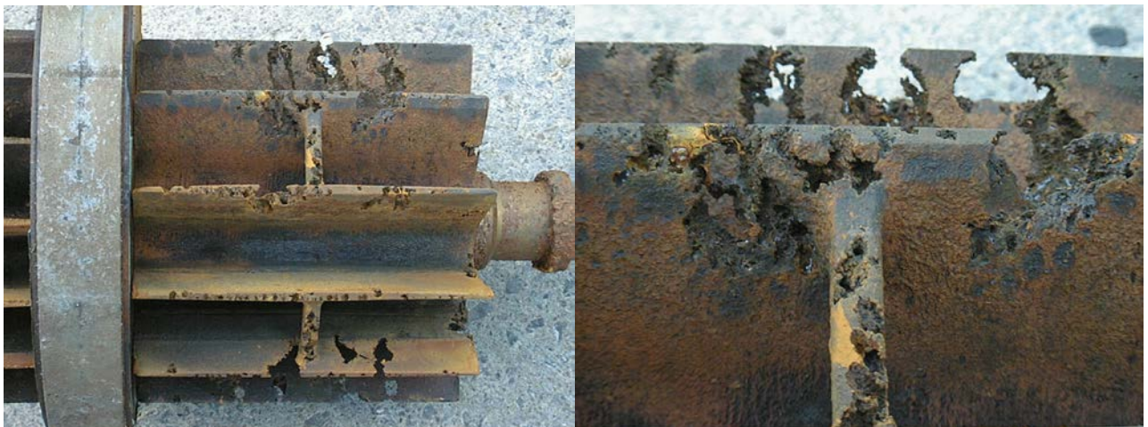
Kavitations skador på vakuumpump
