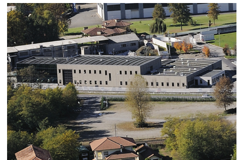
Caleffi S.p.A. - Plant 2 Fontaneto d'Agogna - ITALY
