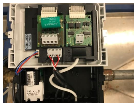
Fig. 7: Anslutningsexempel på temperaturgivare med tvåledar-teknik
